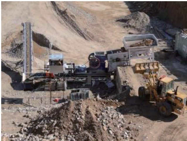
写真 3：瓦礫処理用の移動式破碎ソーティング・プラント
