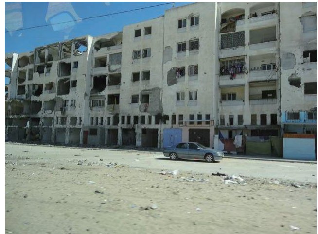
写真 4：瓦礫等が撤去後の破壊されたアパートと街路
